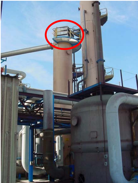
Abb. 4: Kolonne nach Abschluss der Arbeiten
